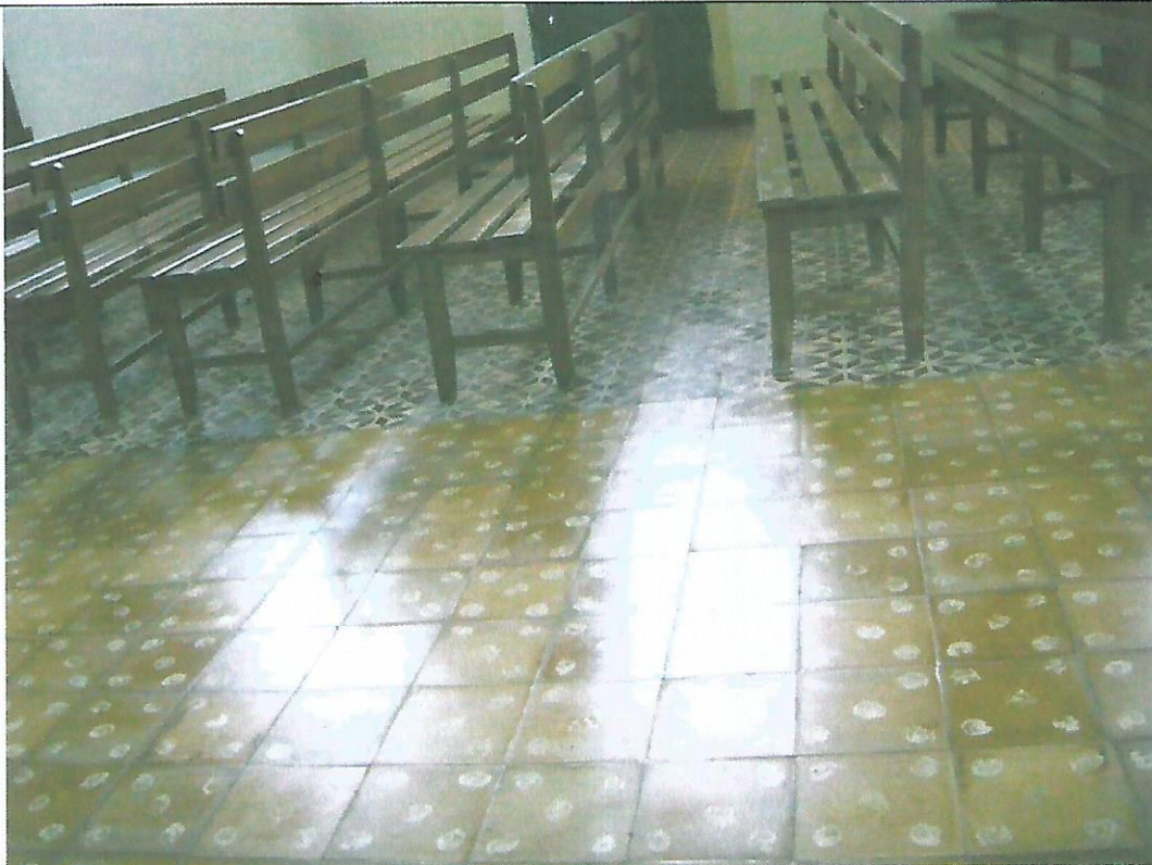
Foto 20- Piso da nave em ladrilho hidráulico em bom estado.
