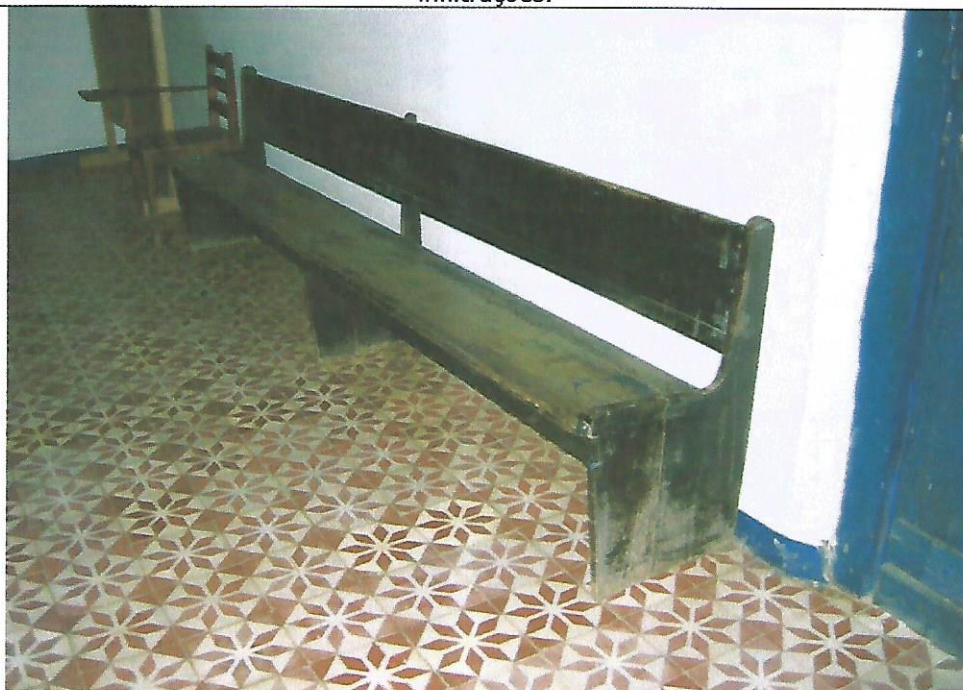
Foto 19 – piso da nave em ladrilho hidráulico em bom estado.
