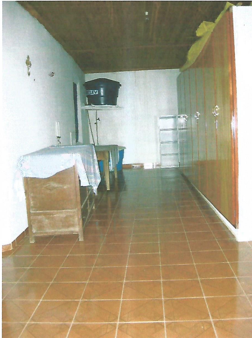
Foto 23- foram colocadas caixas d'água dentro da sacristia atendendo necessidade de lavatório.
