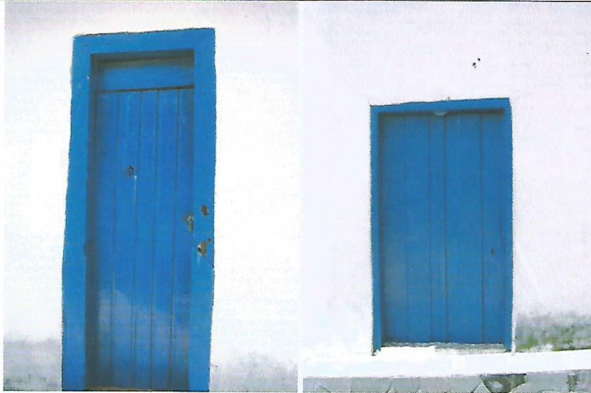
Foto 6- Porta de acesso à sacristia. Foto 7- porta de acesso a nave- fachada lateral direita As esquadrias, principalmente portas parecem ter sido adequadas aos vãos.
