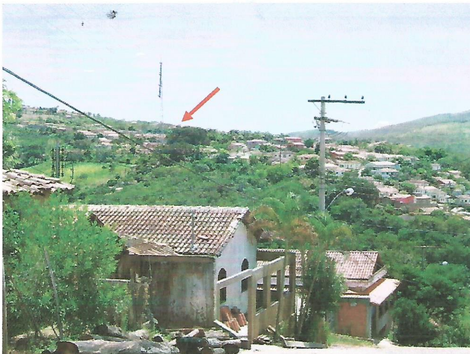
Foto 1- Localização da Igreja do Rosário no alto do Rosário.
