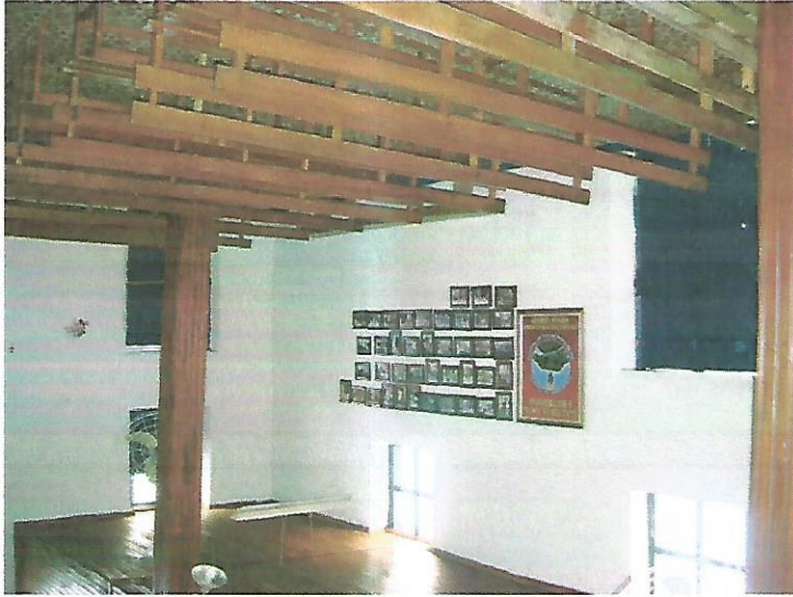
Foto 17- vão de acesso a sala de aula.
