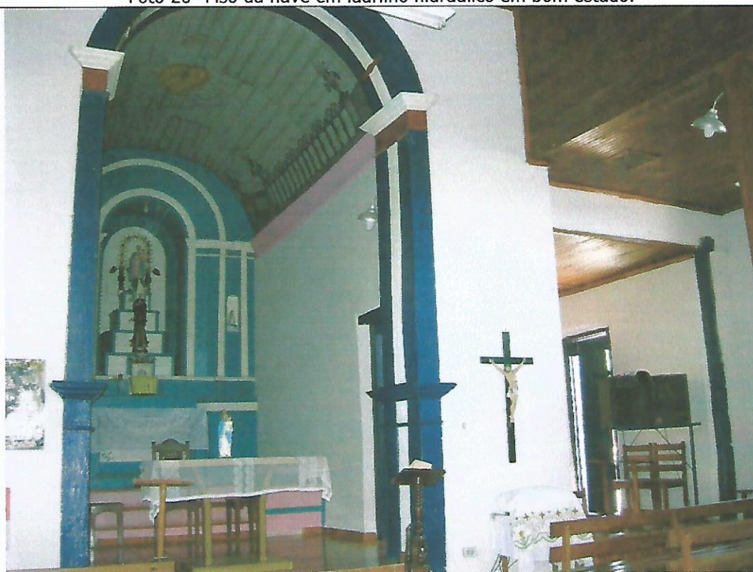
Foto 21- arco cruzeiro bem conservado com pintura mas com áreas atacadas por térmitas.
