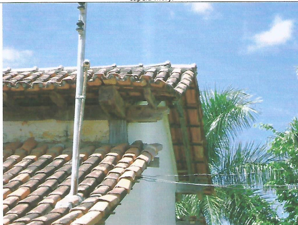
Foto 15 - detalhe beiral capela mor e corredor lateral- fachada lateral esquerda.
