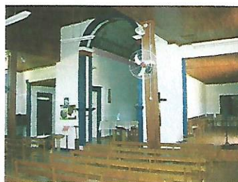
Vista interna arco cruzeiro
