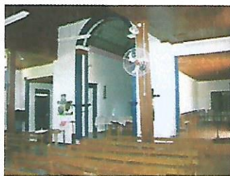
Vista interna arco cruzeiro
