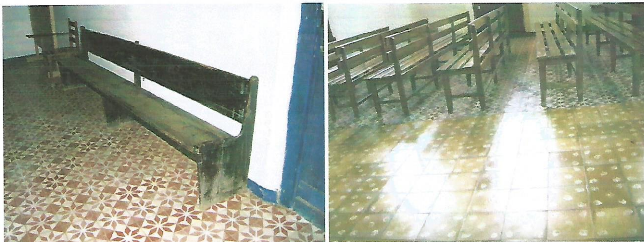
Fotos 19 e 20- piso da nave em ladrilho hidráulico
