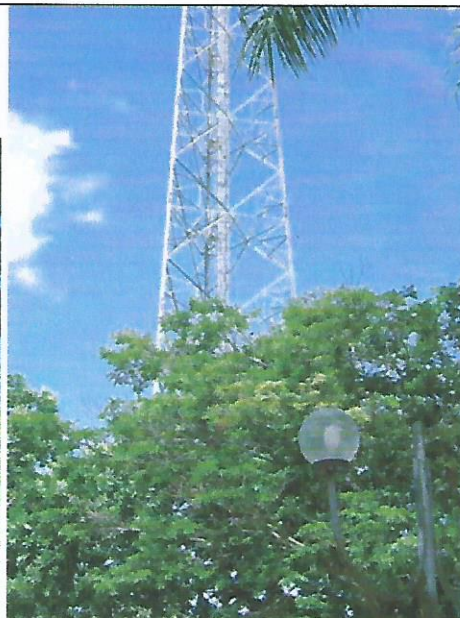
Foto 5- torres de telefonia Estruturas que causam impacto negativo ao entorno da Igreja de Nossa Senhora do Rosário.
