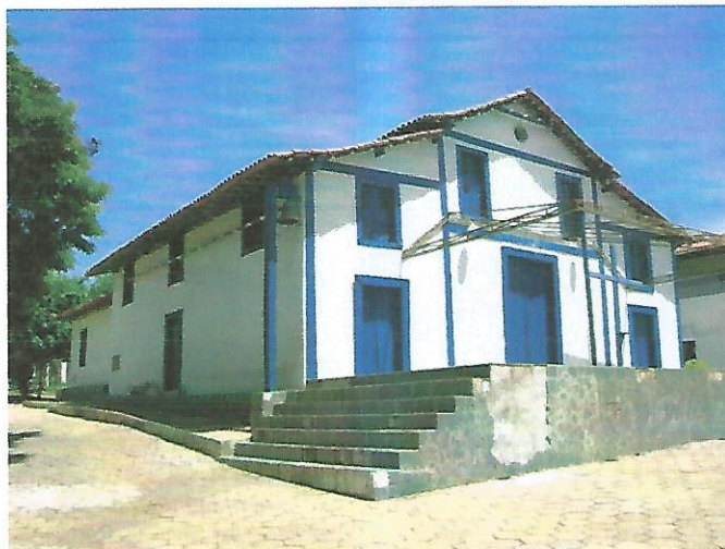
Foto5: Fachada principal e lateral direita
