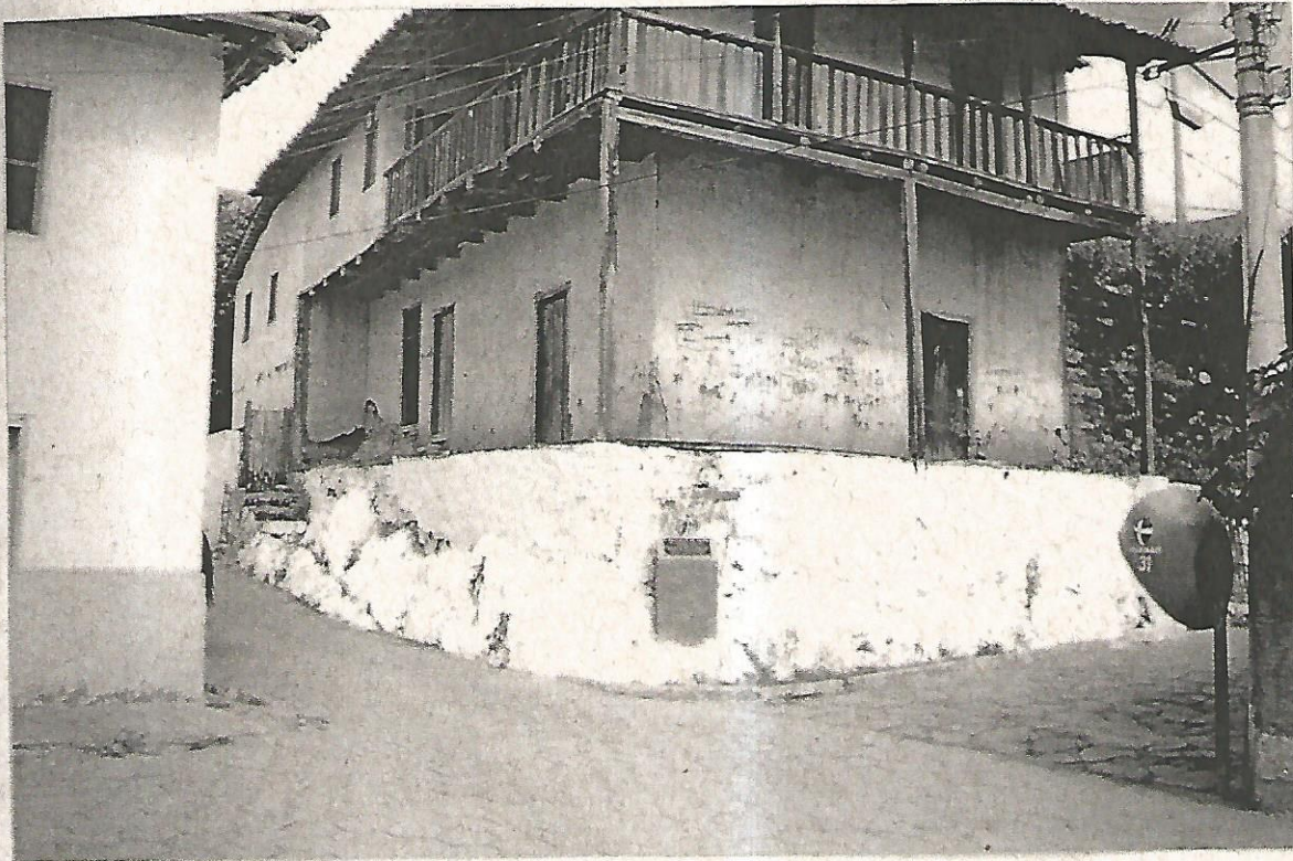
Foto 01 – Vista geral da fachada.
