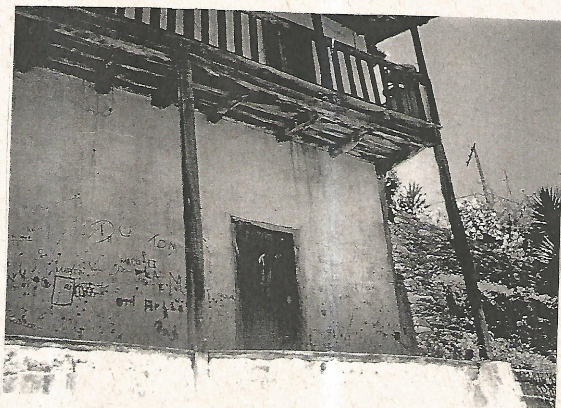
Foto 05 – Detalhe da fachada.
