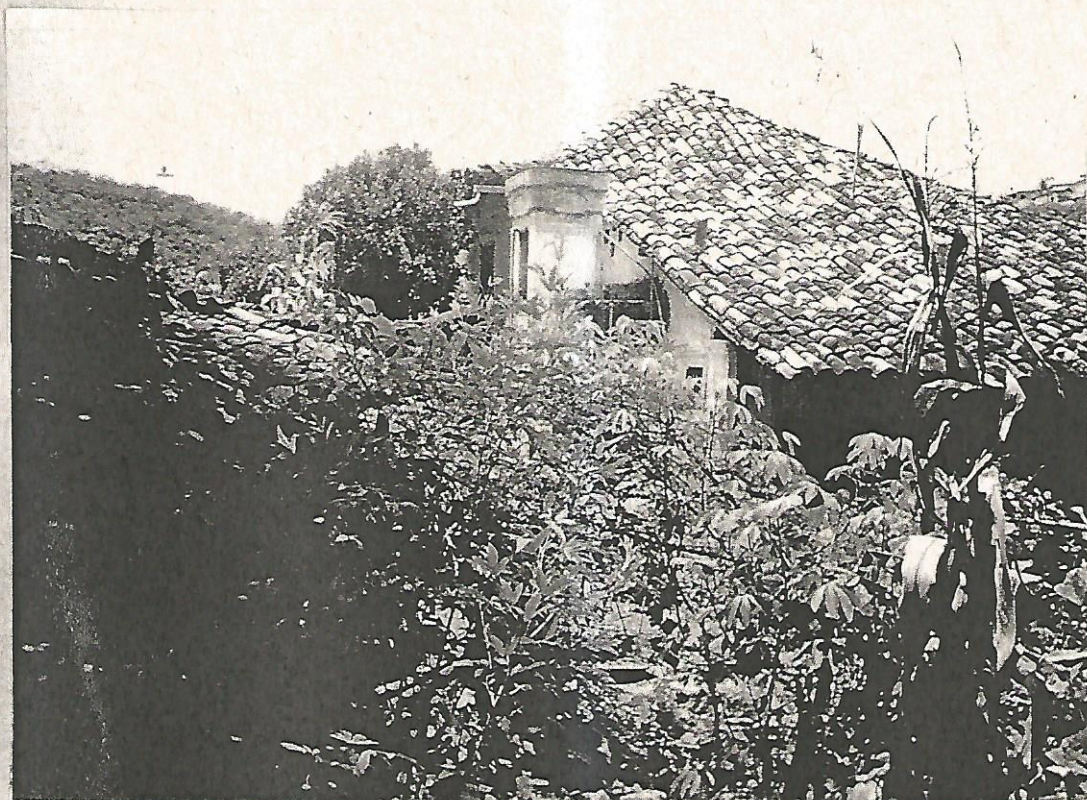
Foto 03 – Fachada dos fundos.
