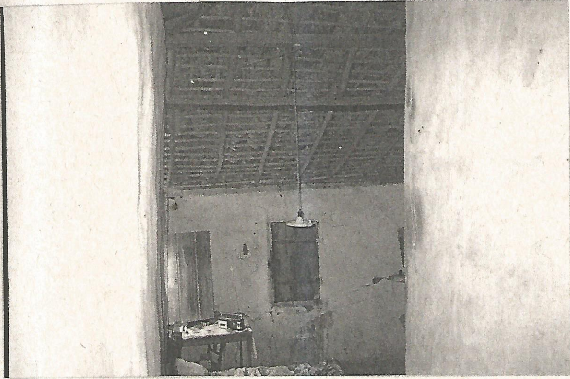
Foto 09 – Vista do interior.
