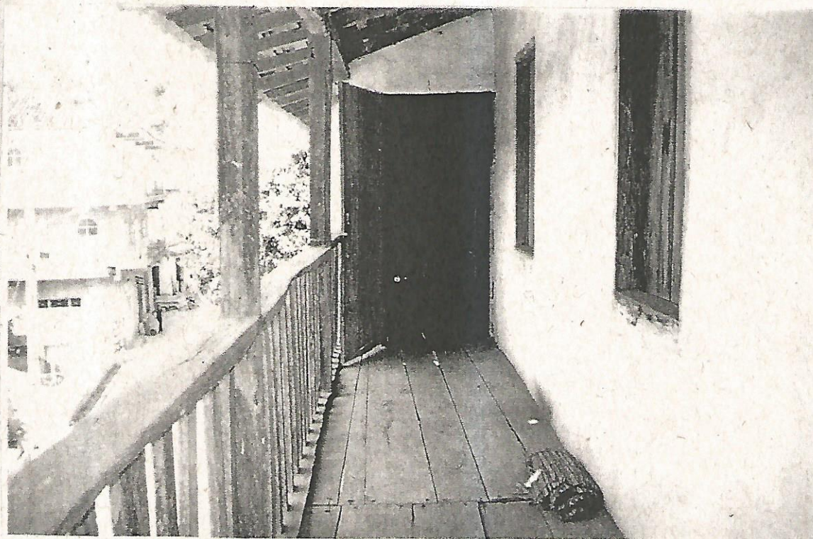
Foto 04 – Vista da varanda e piso.
