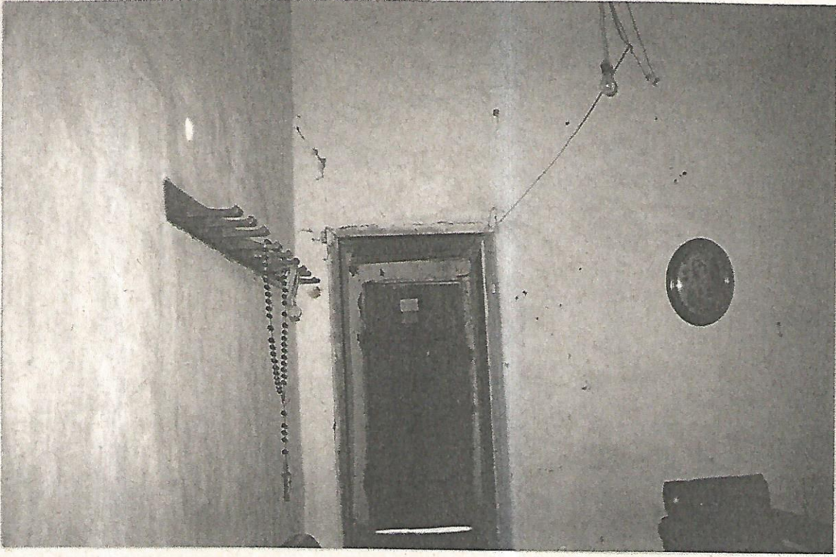
Foto 07 – Vista do interior.
