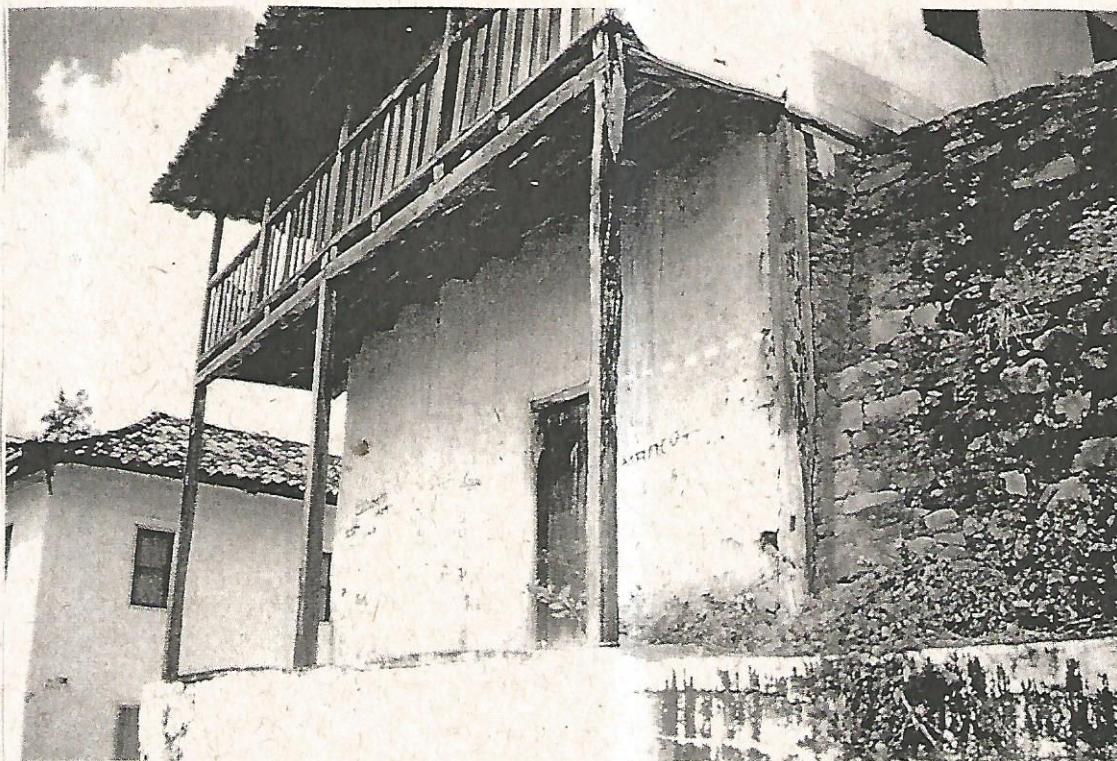
Foto 04 – Vista da fachada.
